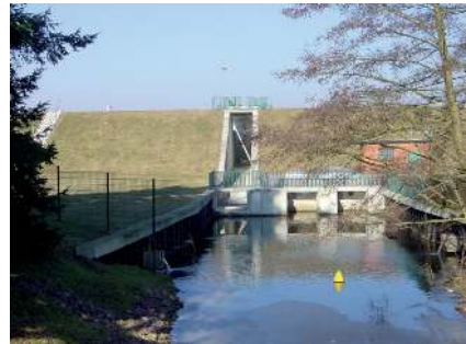
Luftseite des Staudammes am Obersee;
